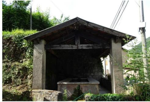
Le lavoir est constitué d'un bassin alimenté en eau provenant du vallon et circulant dans un caniveau maçonné sur les murs, ainsi que d'un étendoir et d'une toiture qui se détériore chaque année. Il est nécessaire de rénover cette toiture le plus rapidement possible car le risque d'effondrement augmente avec les intempéries.
